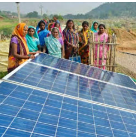
Ob Solarpaneele für Wasserpumpen oder Internet- und Handyzugang: Technik sollte auch für marginalisierte Gruppen da sein, wie hier bei CWS-Bihar. Foto: JB.
