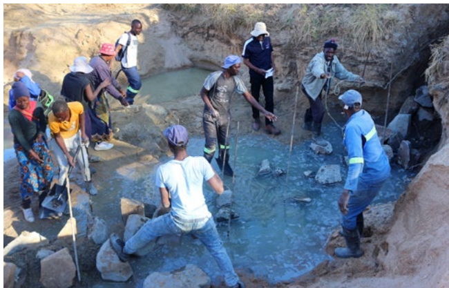
Ein Sanddamm zur Gewinnung und zum Auffangen wertvollen Wassers wird errichtet.
